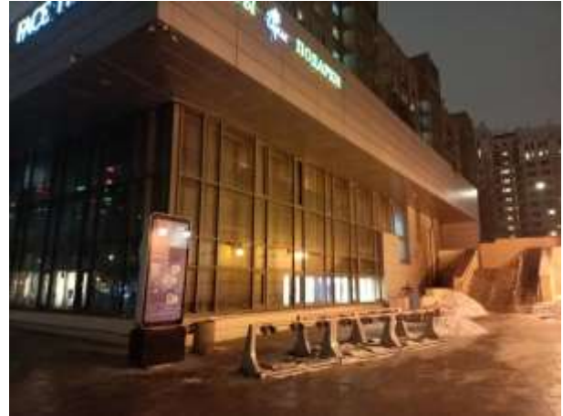
Фото 4. Внешний вид здания
