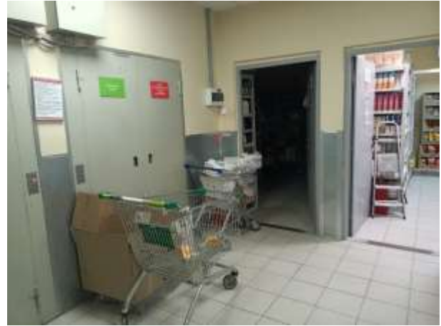
Фото 16. Состояние помещений 1 этажа
