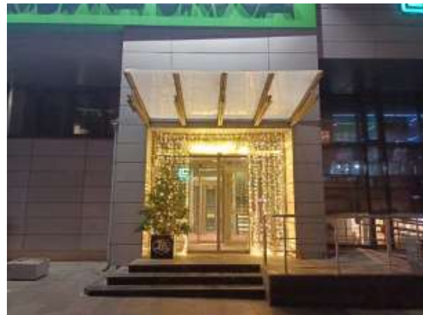
Фото 2. Внешний вид здания
