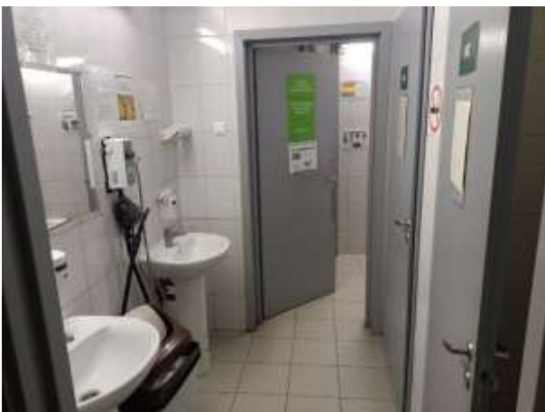
Фото 11. Состояние помещений цокольного этажа
