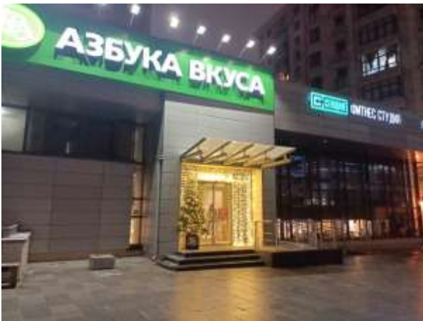
Фото 1. Внешний вид здания
