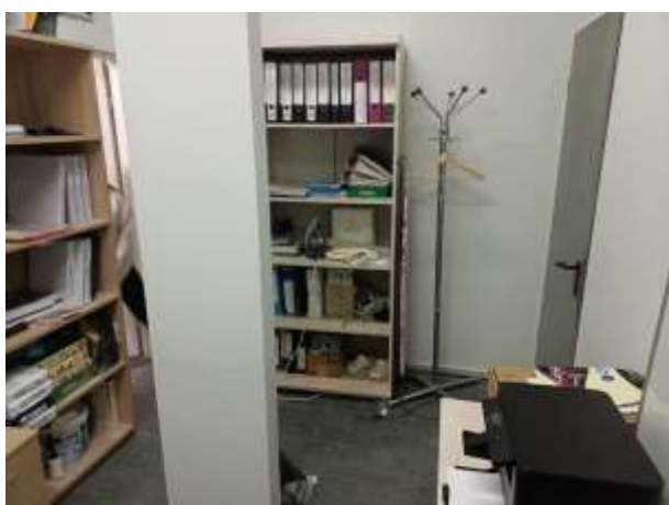
Фото 29. Состояние помещений антресоли 1 этажа
