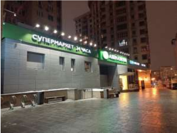
Фото 3. Внешний вид здания
